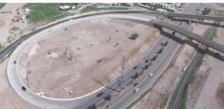
**C**on el Eje Cero del Distribuidor Vial Zootecnia se elimina la vuelta a la izquierda, para incorporarse al Periférico R. Almada será flujo continuo por esta nueva vía.
